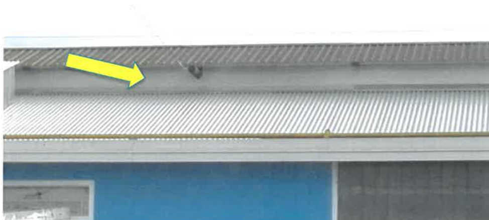
foto 7 – particolare tamponature facciata animisteria
