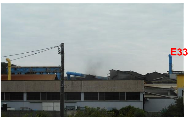
Figura 12 - Visione lungo la direzione indicata dalla freccia verde
