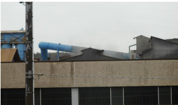
Figura 10 - Visione lungo la direzione indicata dalla freccia verde
