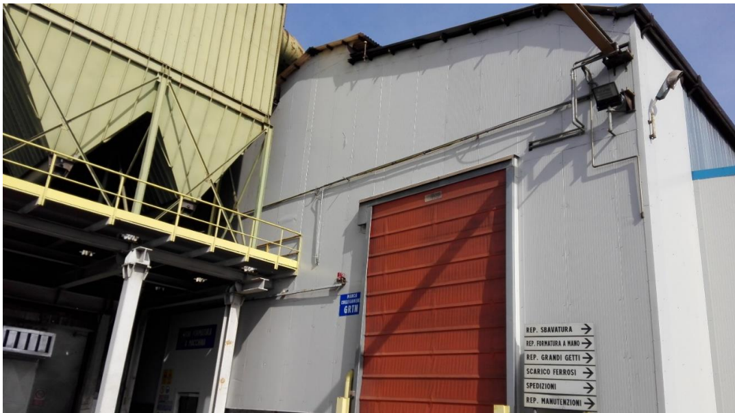
foto 2 – insonorizzazione testata capannone forni
