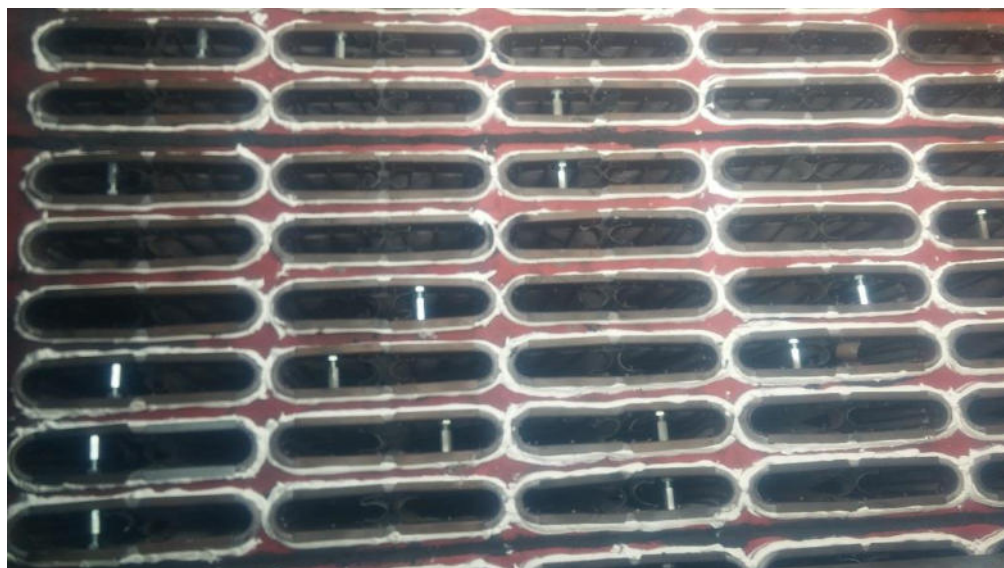
foto 2 – inserimento distanziatori e siliconatura collari
